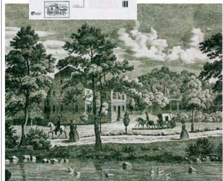
HISTORICKÉ POŠTOVNÍ BUDOVOY KARLOVY VARY, SLOVENSKÁ 509 Objekt nechal roku 1791 postavit poslední dědičný karlovarský poštovník Josef Korb von Weidenheim pro výměnu koní, poštovních spřežení a dostavníků. Litografie J. Schwanzara, vydal C. Henning, 1. pol. 19. století, Sběrka Poštovního muzea, Praha.
